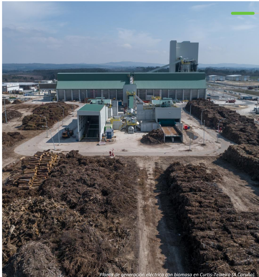
Planta de generación eléctrica con biomasa en Curtis-Teixeiro (A Coruña).
